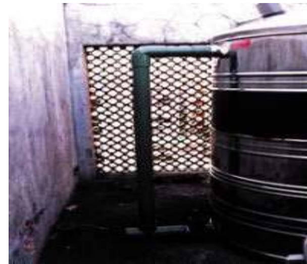
國立雲林科技大學宿舍已設置中水道之後馬桶供水系統
